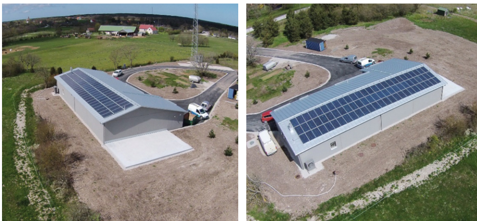
Solceller på taket på en av Region Gotlands VA-anläggningar.
