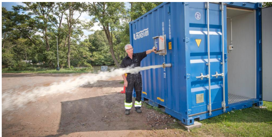
Driftteknikern Gert Bengtsson visar den nya vattenkiosken. För att tanka kopplas en slang till uttaget. Bild: Jari Väliatalo.
