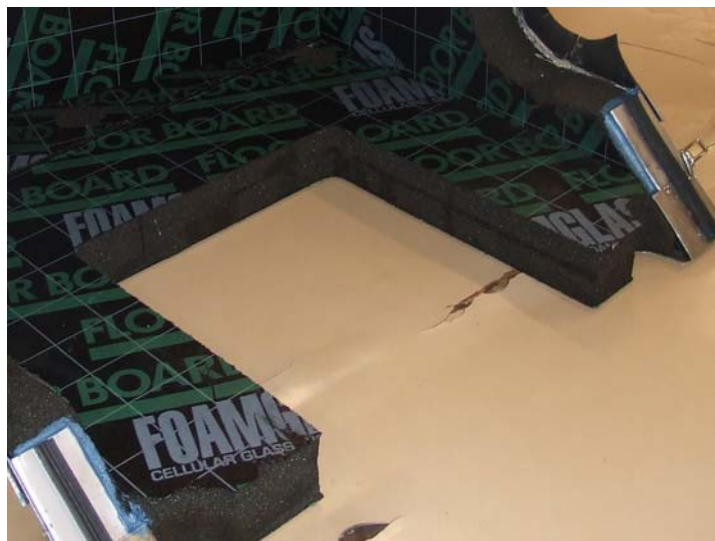
Figur 20, Bild på urtagning i temperaturhuv
