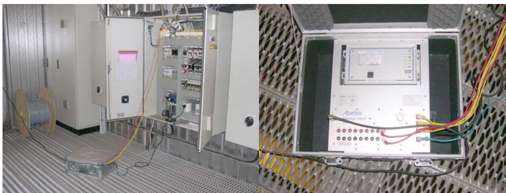
Figur 5.1. Bilderna visar mätväska EE9/3 inkopplad på kammartork 21.
