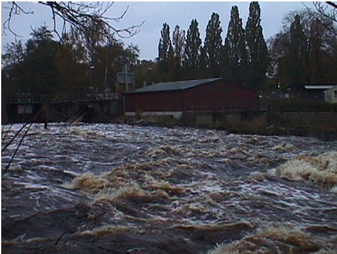
Figur 1.2 Foto på KLE K2. I förgrunden syns den gamla åfåran. Normalt är den gamla åfåran torrslagd, men när bilden togs var vattenföringen större än vad kraftverket kan ta emot. Till vänster i bakgrunden syns dammen. I mitten av bilden syns själva kraftverket med intaget längst bort och utloppet närmast i bilden.
